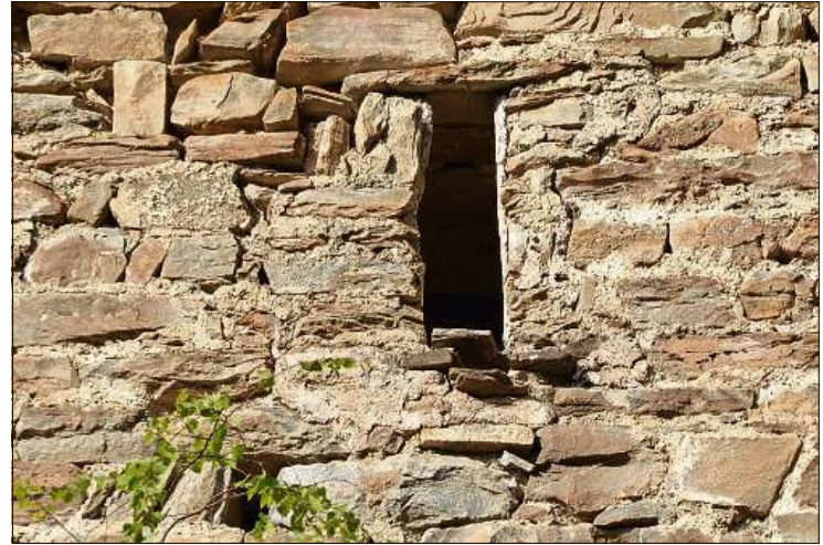
Unten am Schartenfenster: Öffnung für die Wasserzuleitung (damals wohl über einen Holzkänel).
