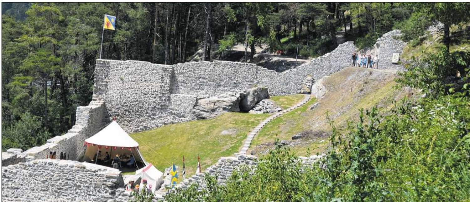
Blick auf die restaurierte Talsperre der Burg Juvalt.
