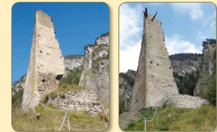
Vorzustand 2010 und gesicherter Turmrest 2012.
