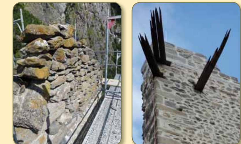
Vorzustand und gesicherte Turmkrone mit ergänzten Kragbalken.
