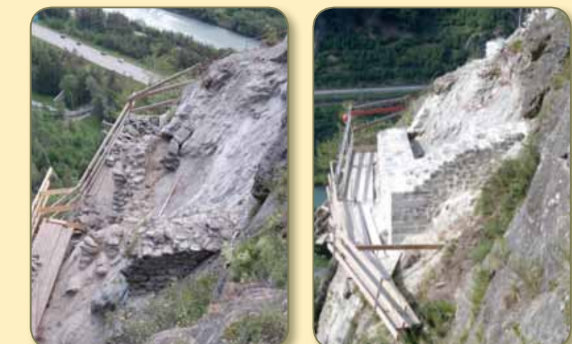
Südostpalas nach der Grabung und vor dem Ausgerüstet.
